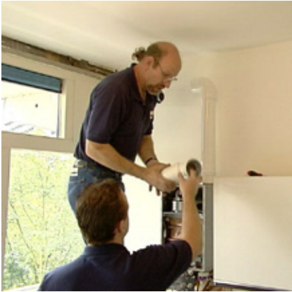
Gesloten geiser met doorvoer onder het balkon. Foto's: Vestia Den Haag Zuid-Oost
