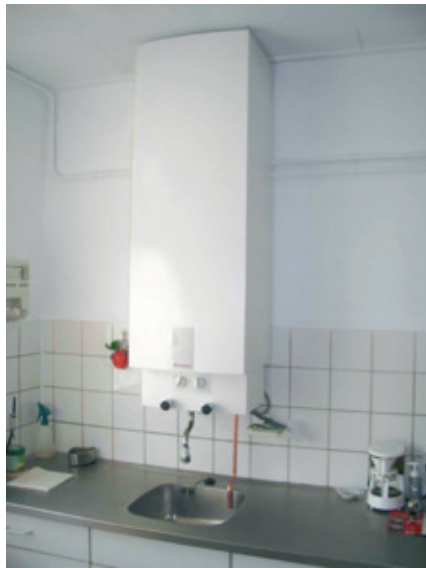
Elektrische geiservervangende boiler op dezelfde plaats. Foto's: Inventum b.v.
