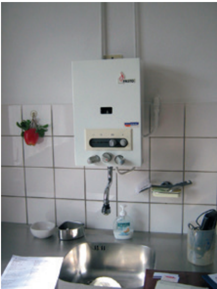
Keukengeiser in bestaande situatie
