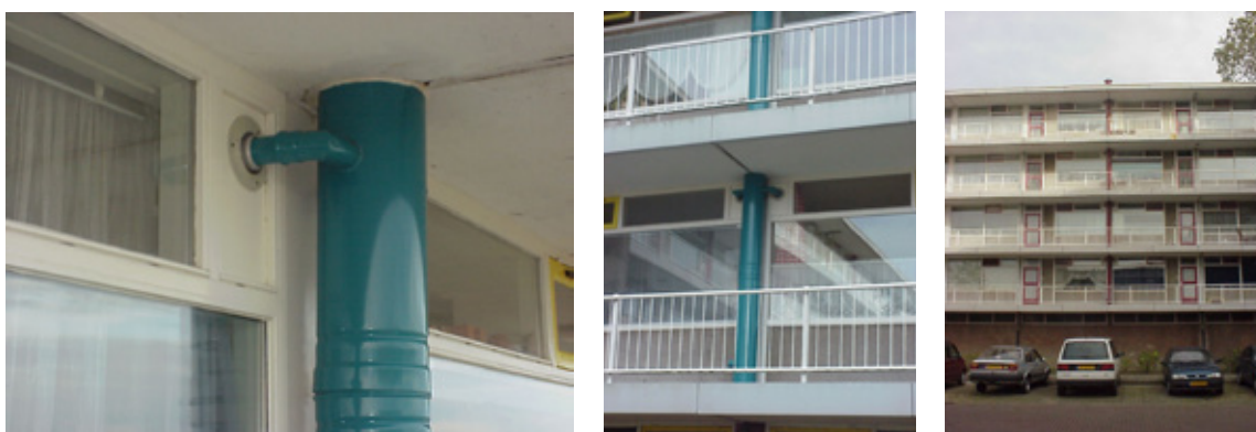
. Aansluiting gesloten toestel op collectieve rookgasafvoer buiten (CRB). Foto's: Vestia Den Haag Zuid-Oost
