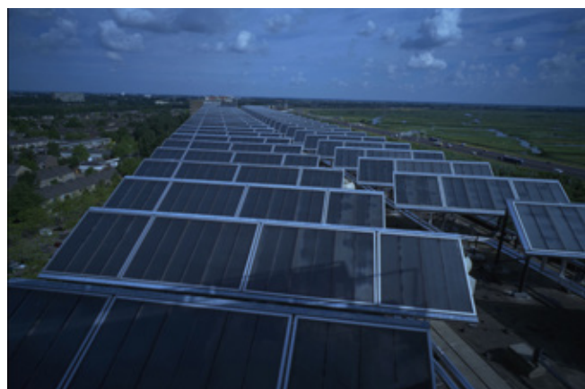
Collectieve zonneboiler op complex Brandaris te Zaandam. Collector oppervlak 760 m 2 .
