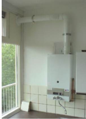
Gesloten geiser met doorvoer onder het balkon. Foto's: Vestia Den Haag Zuid-Oost
